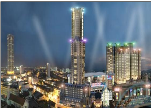
Foto 37: Gambaran Penang Times Square yang dicadangkan. (Sumber: http://penangtimessquare.com/nov2006 )
