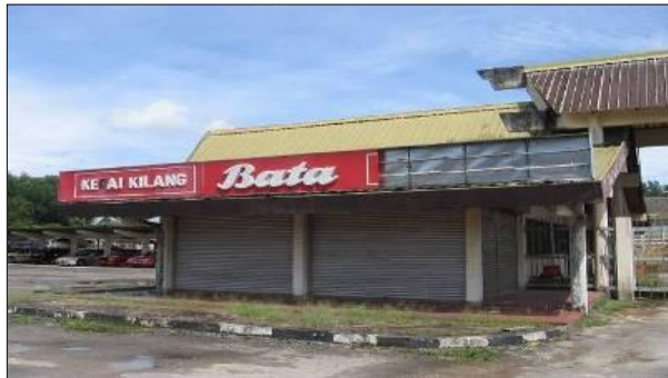
Foto 23: Kilang terbiar di Seremban, (Mac 2007).
