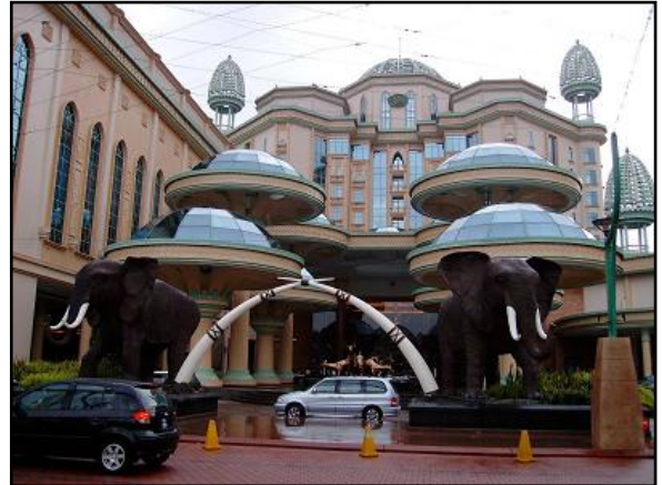
Foto 9: Pembangunan hotel di Sunway Pyramid, Selangor, (Mac 2007).
