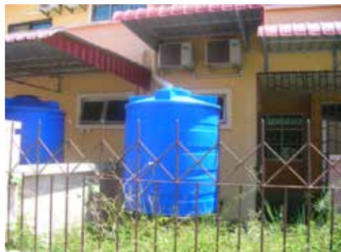
Rajah 7.7: Contoh-Contoh Kaedah dan Peralatan Penuaian Air Hujan Di Premis Kediaman
