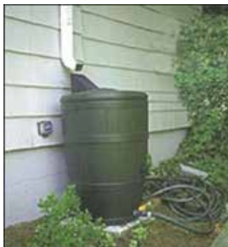
Rajah 7.7: Contoh-Contoh Kaedah dan Peralatan Penuaian Air Hujan Di Premis Kediaman
