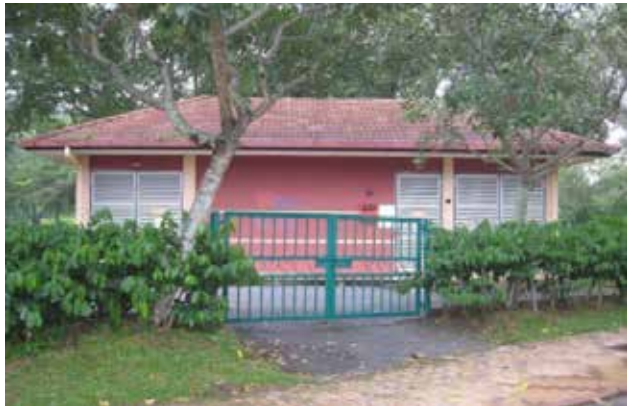
Contoh Pencawang elektrik (PE)
