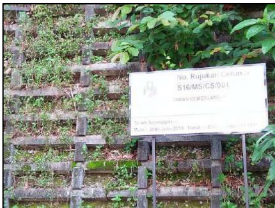
Rajah 7: Pemasangan papan tanda di lokasi cerun Taman Cemerlang oleh Majlis Perbandaran Selayang
