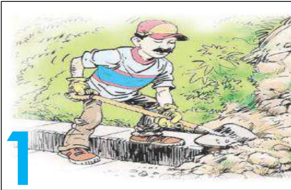
Saliran permukaan catchpits dan sand traps
