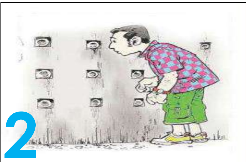
Salur air leleh ( weepholes ) dan saluran longkang
